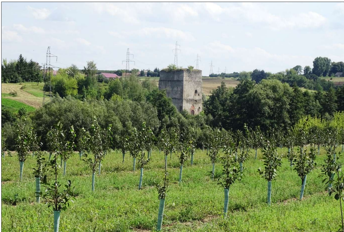
Widok ogólny na wieżę; fot. 2018 r.
