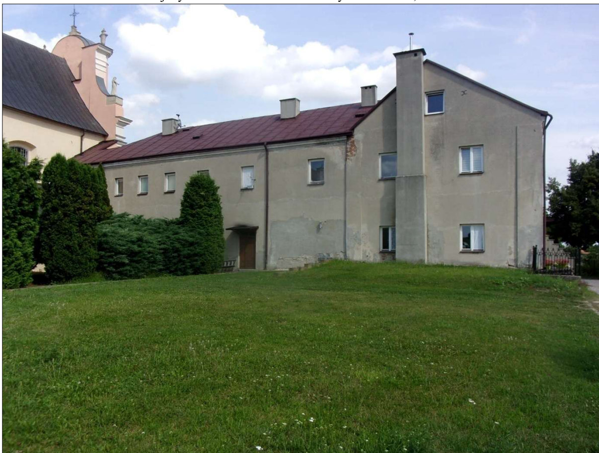
Wschodnie skrzydło klasztoru – widok od strony dawnego sadu klasztornego; fot. 2024 r.
