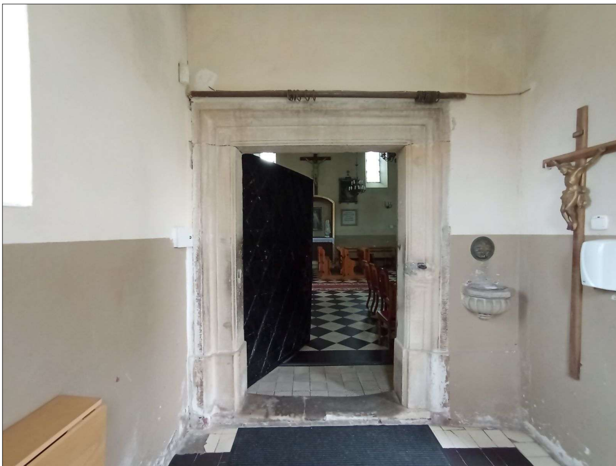
Wejście boczne z kruchty do nawy kościoła – drzwi jednoskrzydłowe obite blachą z dekoracją z płaskownika w romby w obramieniu kamiennym profilowanym; fot. 2024 r.
