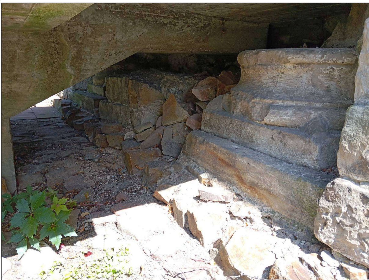
Pod schodami prowadzącymi do wejścia głównego – bazy dawnych kolumn, na których opierały się łuki arkad; fot. 2024 r.
