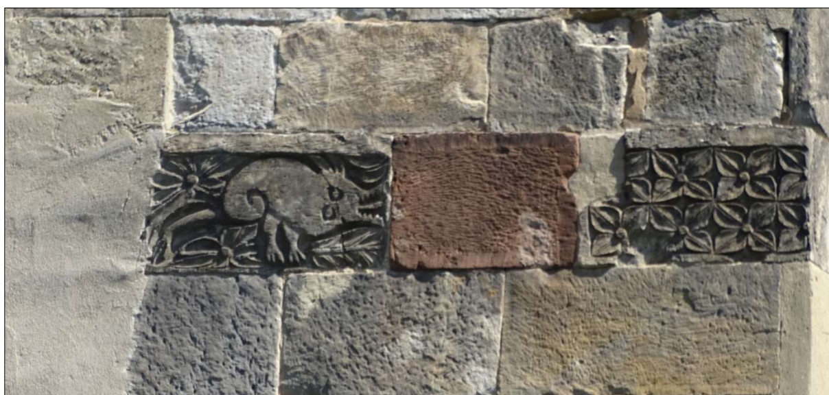
Fragmenty fasady z wysokim i wąskim oknem znajdującym się powyżej portalu głównego zapewne z XVI w. oraz płaskorzeźbionym ozdobnym fryzem romańskim z motywem zoomorficznym i czwórliścia; fot. 2024 r.
