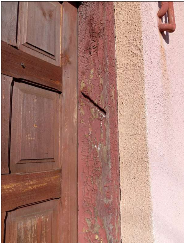
Kamienica przy ul. Szerokiej 18; w ościeżach drzwi wejściowych zachowany ślad po mezuzie; fot. 2024 r.
