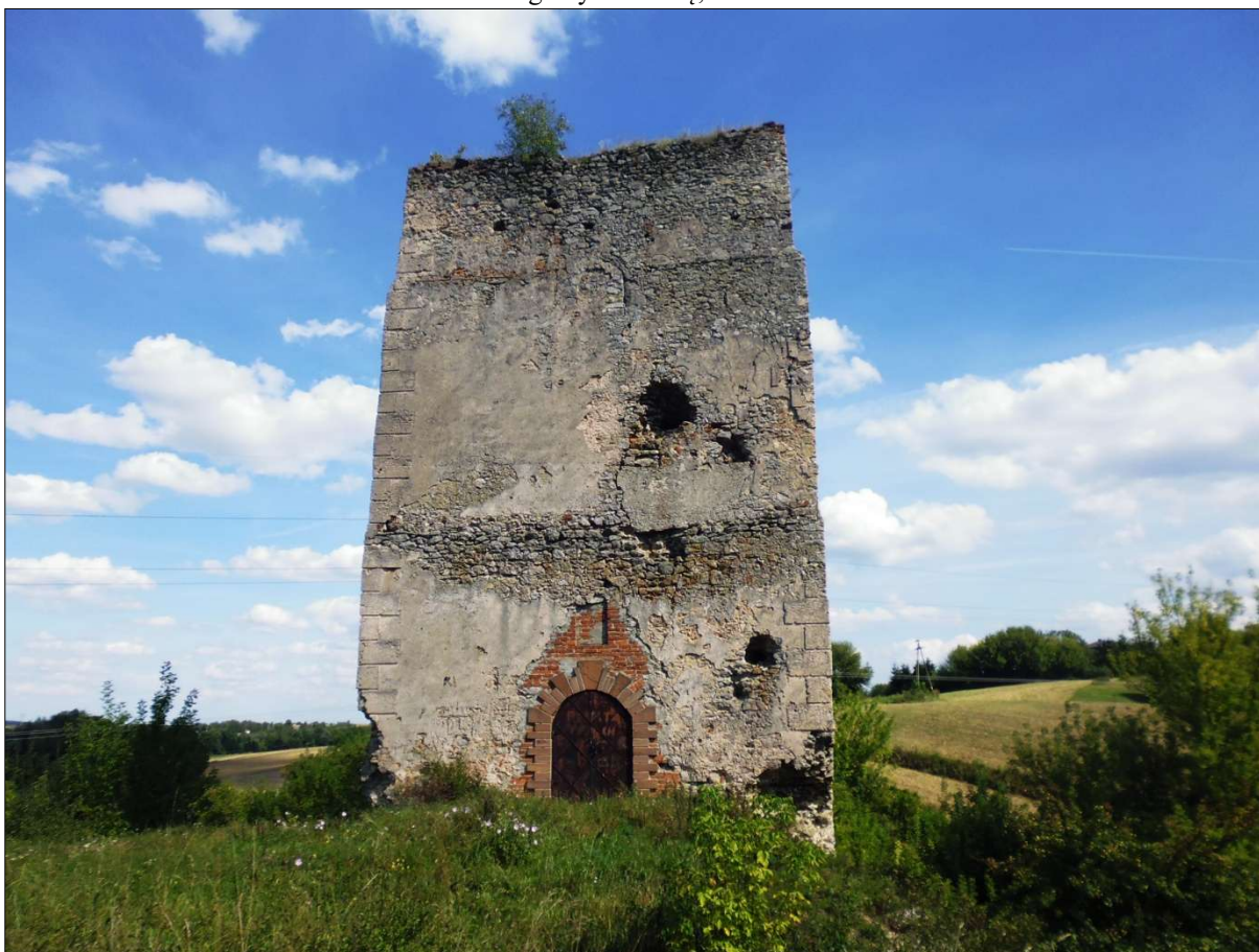
Elewacja wschodnia wieży; fot. 2018 r.
