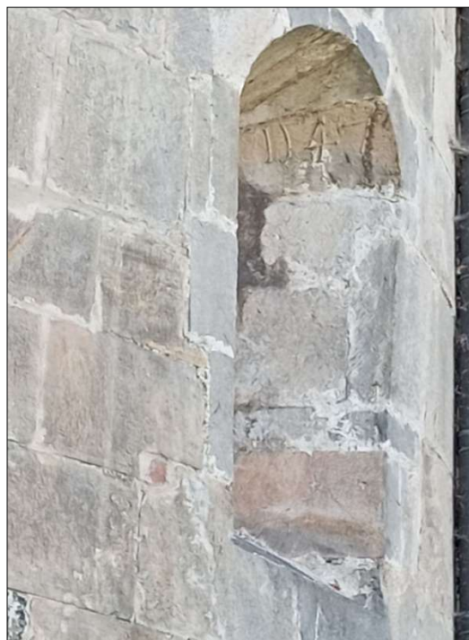
W glicie okienka absydy północnej wykuta data restauracji – 1547; fot. 2024 r.
