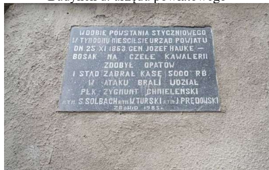
Frag. wschodniej ściany budynku z tablicą pamiątkową
