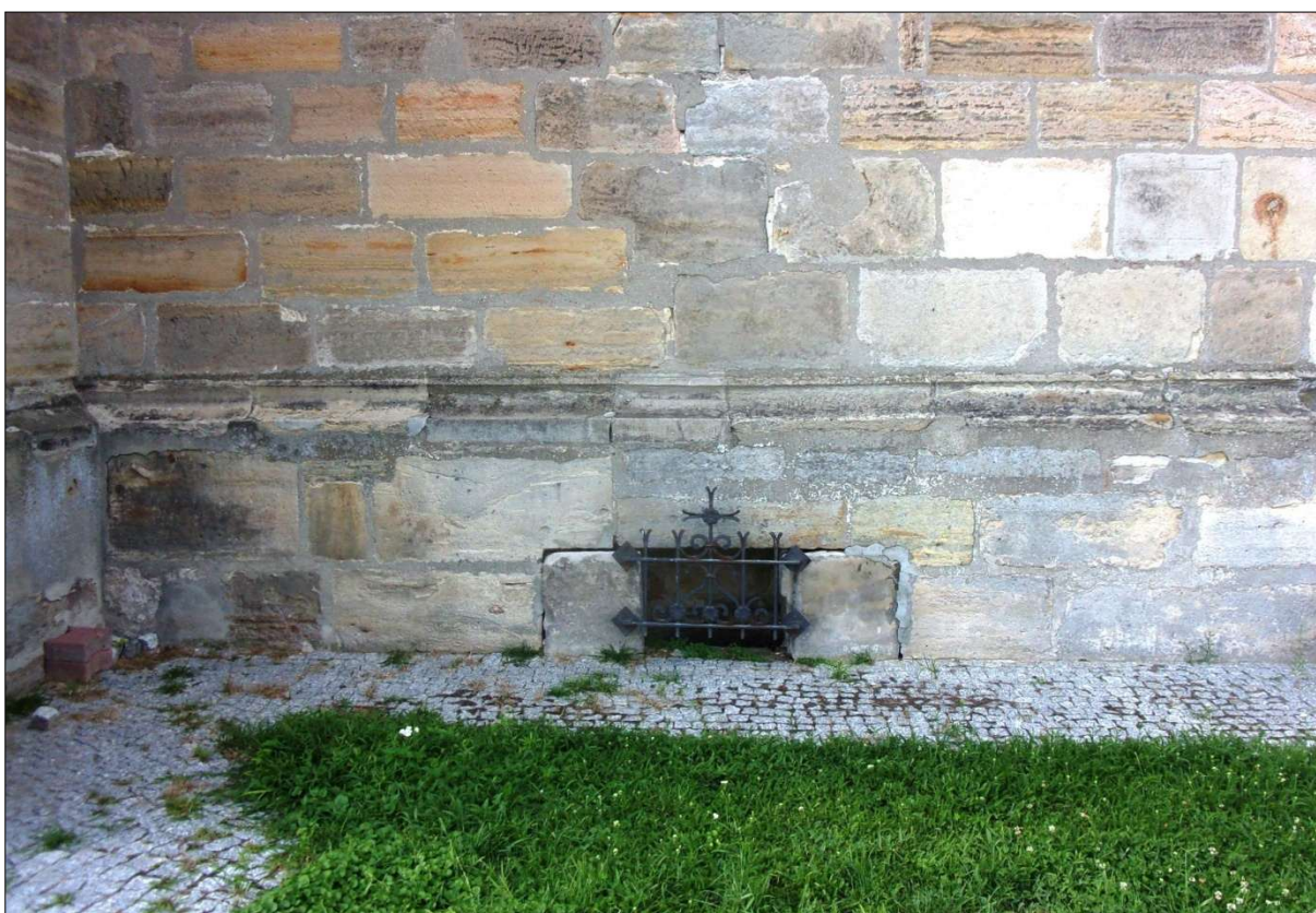
Odkryte wejście do krypty przysłonięte kratką – w południowej ścianie prezbiterium; fot. 2024 r.
