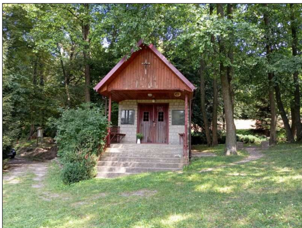
Widok ogólny; fot. 2024 r.
