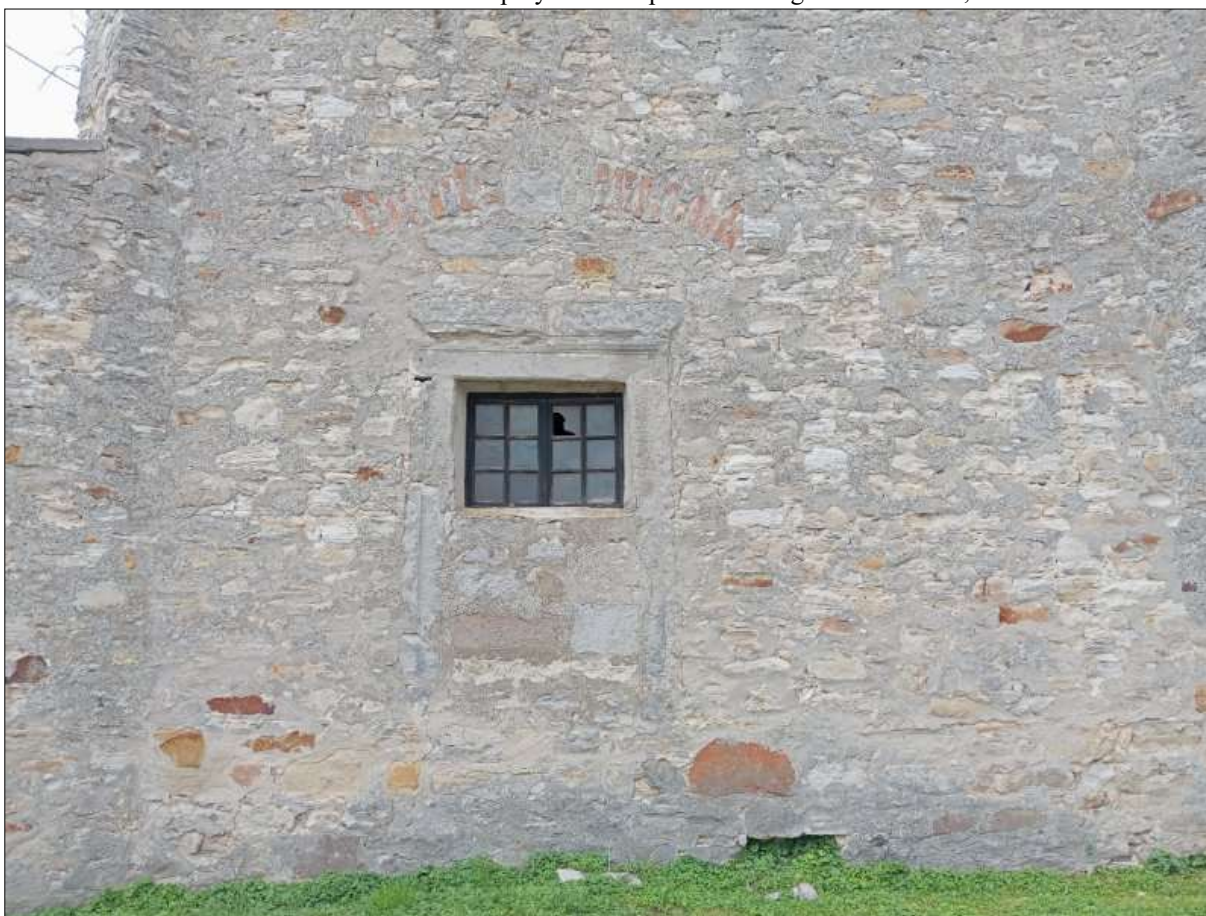
Dzwonnica przy kościele pw. św. Idziego; elewacja zachodnia z zamurowanym częściowo oknem; fot. 2024 r.
