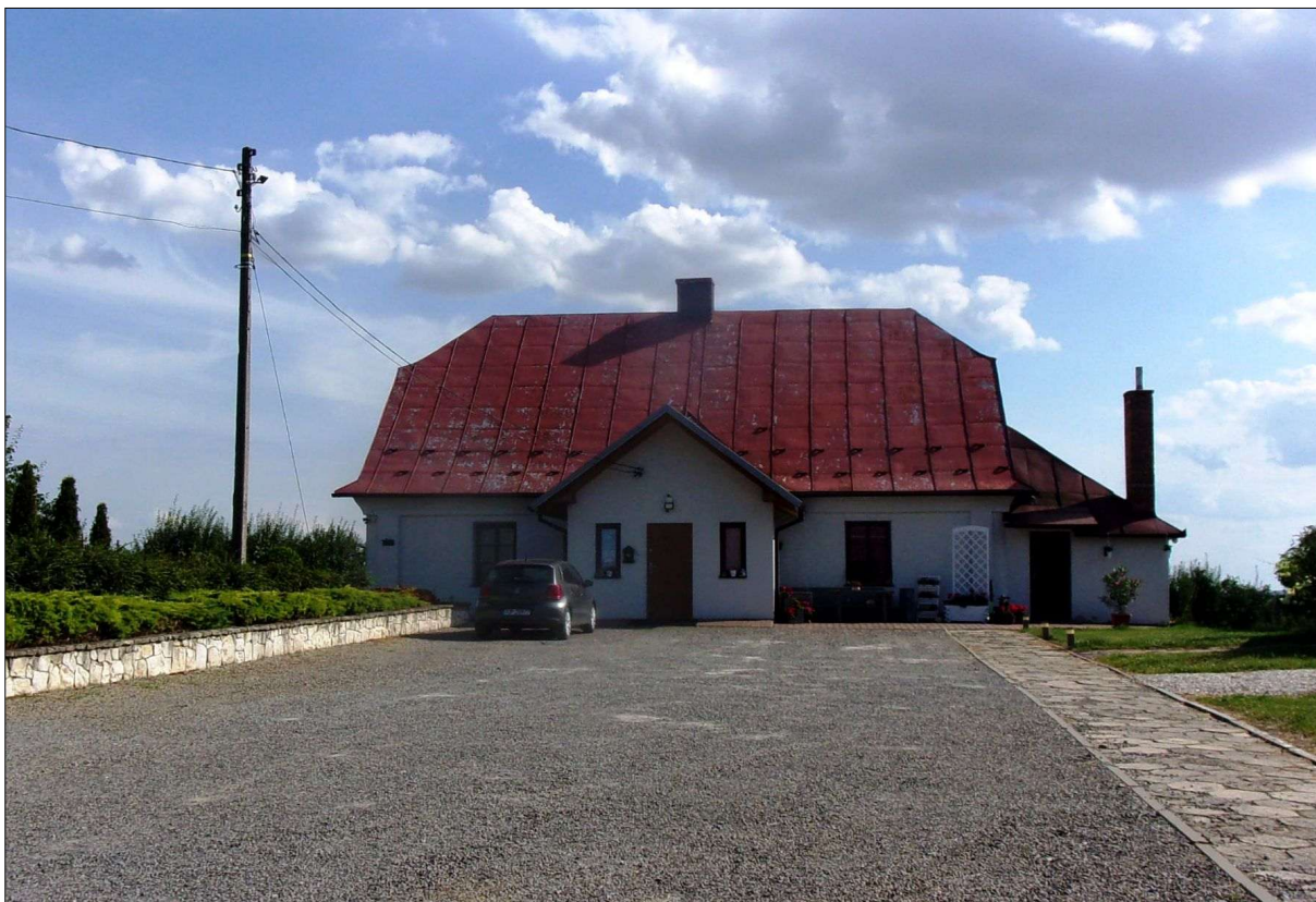
Plebania z 1789 r. przy zespole kościoła parafialnego w Ptkanowie –widok na fasadę; fot. 2024 r.
