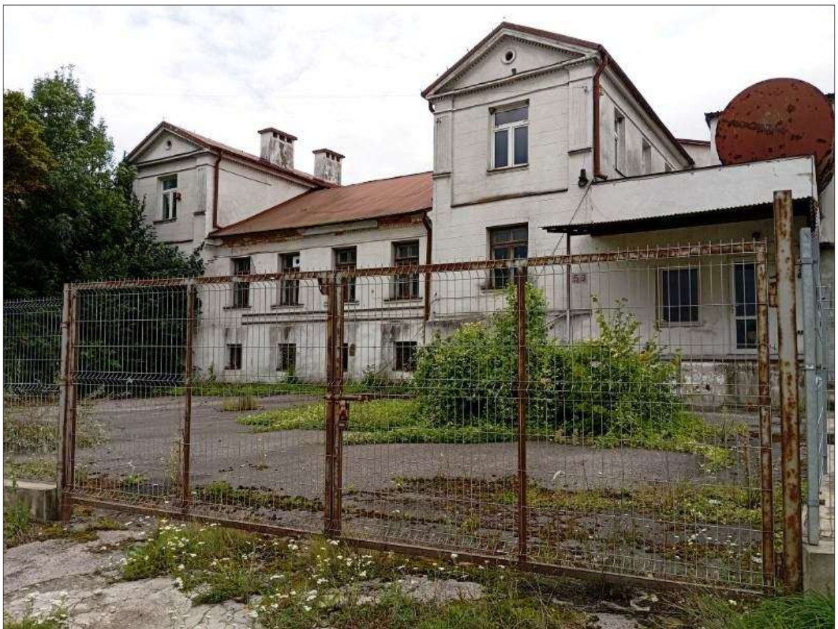
Zabudowania przemysłowe w Opatowie, przy ul. Henryka Sienkiewicza 44; fot. 2024 r.
