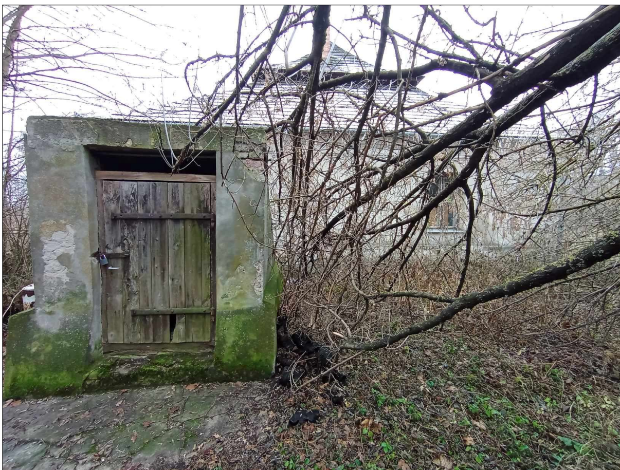
Dwór w Nikiszałce Małej – elewacja boczna; fot. 2024 r.
