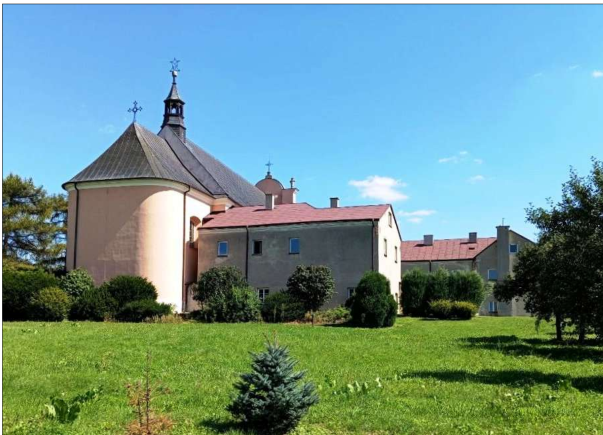
Elewacja tylna kościoła i zachodnie skrzydło klasztoru; fot. 2024 r.
