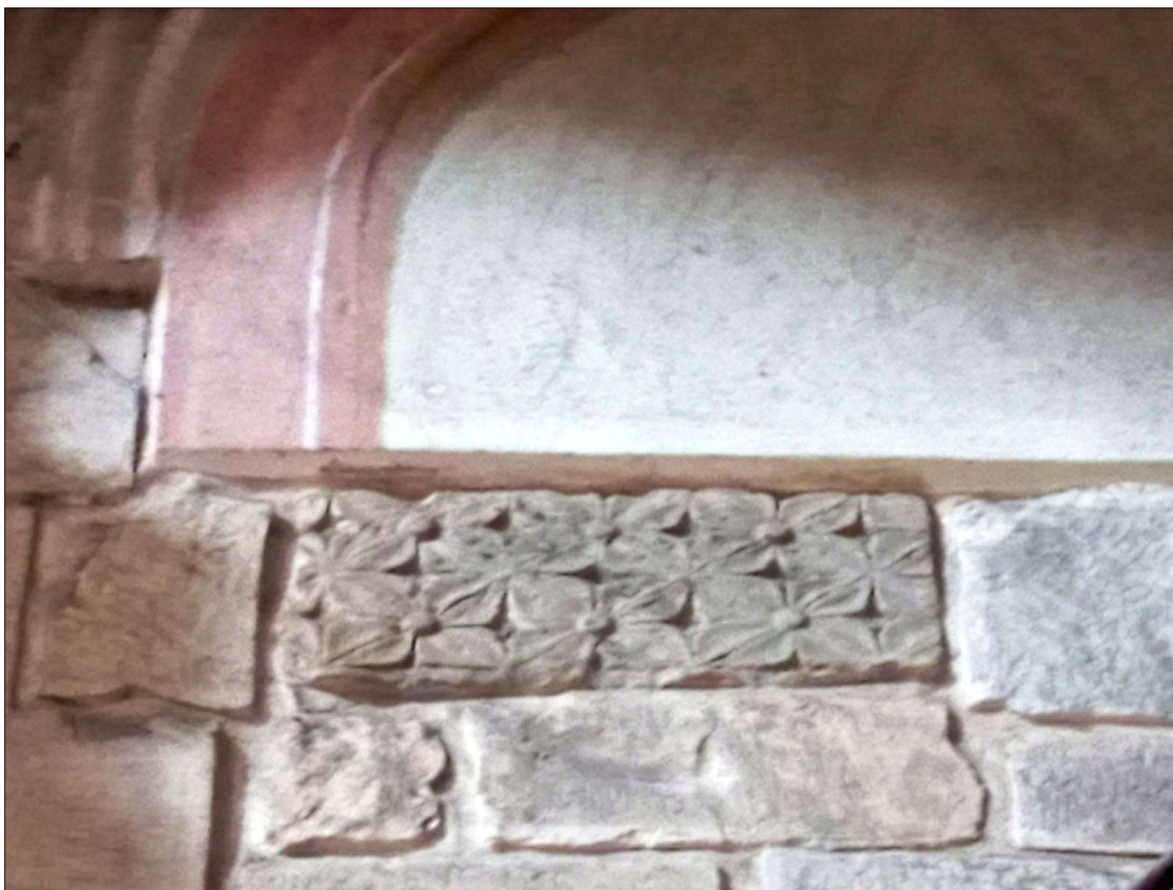
Cios z motywem czwórliścia wtórnie wmurowany – zachodnia ściana kościoła, przy żeliwnych krętych schodach prowadzących na chór i północną wieżę; fot. 2024 r.
